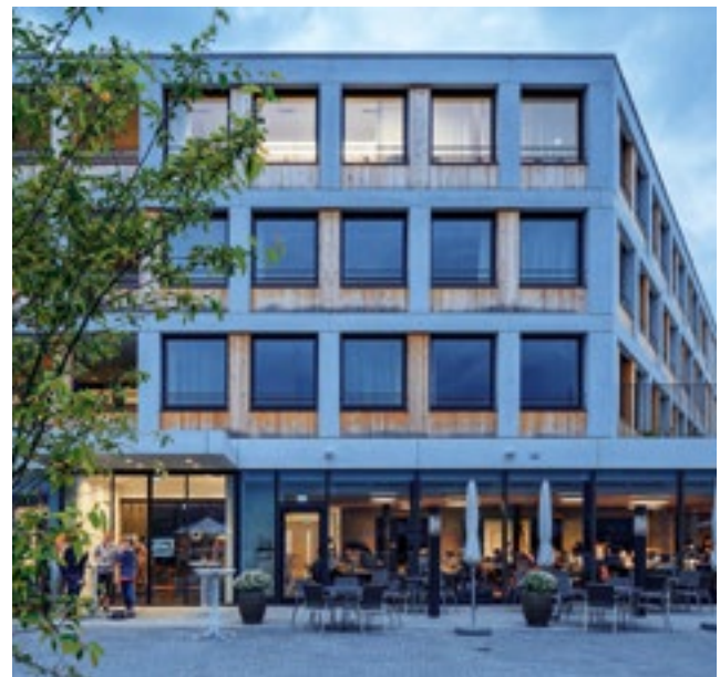
Aussenansicht des Alterszentrums Appenzell. Im obersten Geschoss gut erkennbar ist die dynamische Lichtdecke. Die Lichtdecken in den Aufenthaltsräumen werden über Bewegungsmelder aktiviert.
